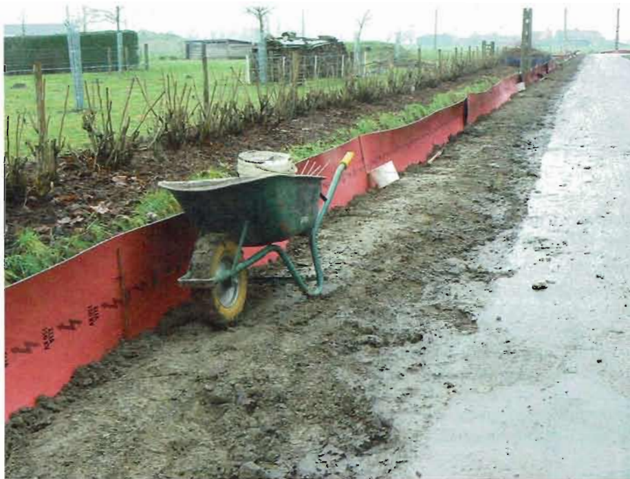
Door een aanpassing van haar werfinrichting en de introductie van een geleidingscherm werd de jaarlijkse paddentrek nauwelijks verstoord.
